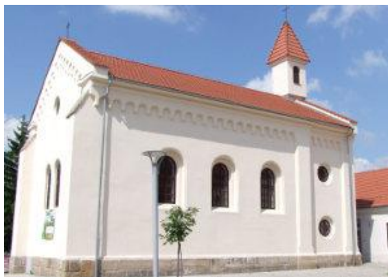
Bývalá věžeňská kaple
